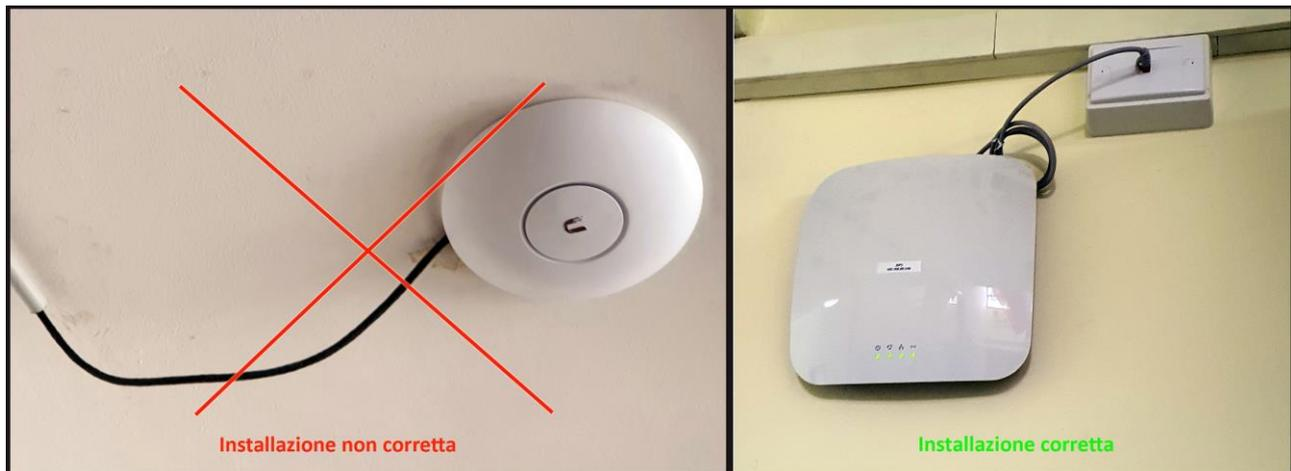
Figura 10 – Installazione corretta dell'Access Point
